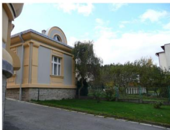
Současný stav – západní část zahrady, před domem správce
